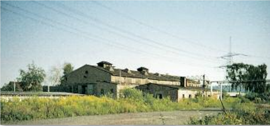
Alte Produktionshalle - Abriss 1992
