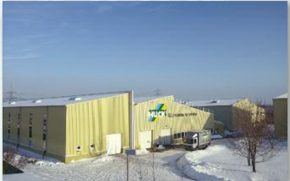
Neubau Werk Heidenau Januar 2011
